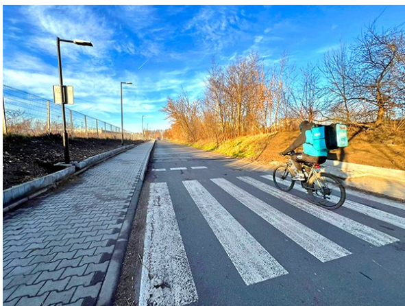
Fot. 23 Remont nawierzchni ulicy Kopalnianej wraz z nowymi chodnikami i oświetleniem
