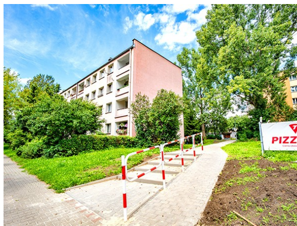
Fot. 26 Remont chodnika przy ul. Andersa
