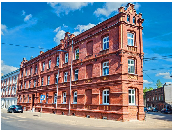
Fot. 31 Remont kamienic przy ul. Matejki
