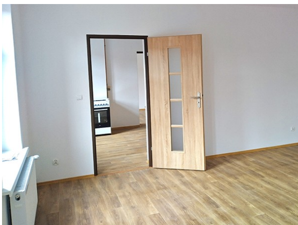
Fot. 33 Remonty pustostanów (61)
