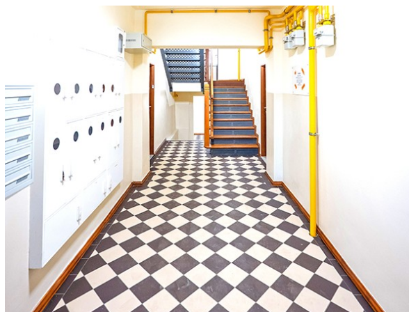
Fot. 32 Remont klatek schodowych przy ul. Matejki
