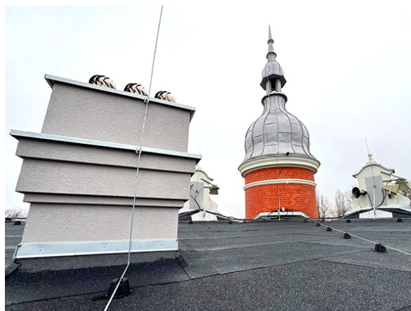
Fot. 34 Modernizacja zabytkowego ratusza
