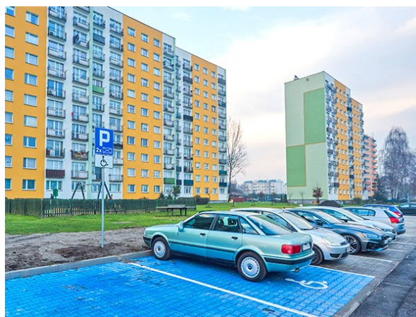
Fot. 28 Budowa parkingu przy ulicy Wyzwolenia
