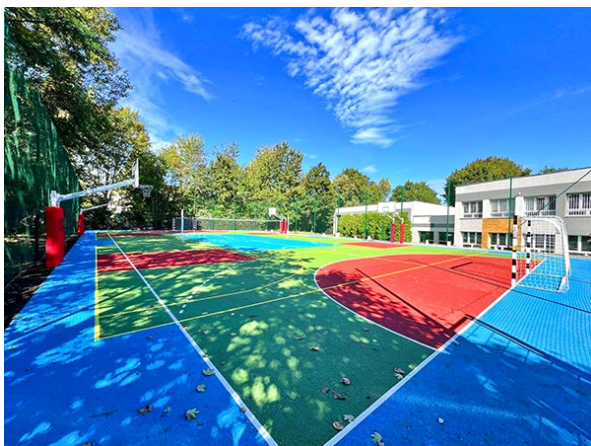
Fot. 35 Budowa boiska przy ZS Meritum
