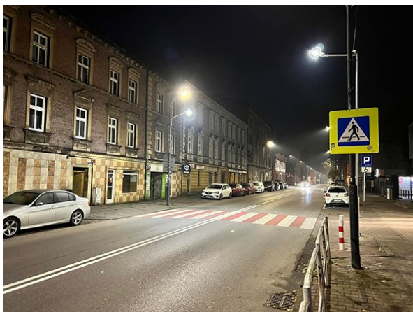
Fot. 29 Doświetlenie przejścia dla pieszych w rejonie ulicy Powstańców 34 - 54
