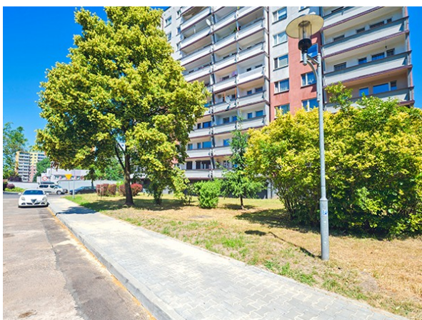
Fot. 27 Wymiana nawierzchni chodnika przy ulicy Niepodległości
