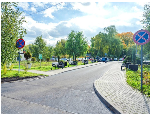
Fot. 25 Nowy układ drogowy na terenie Szpitala Miejskiego
