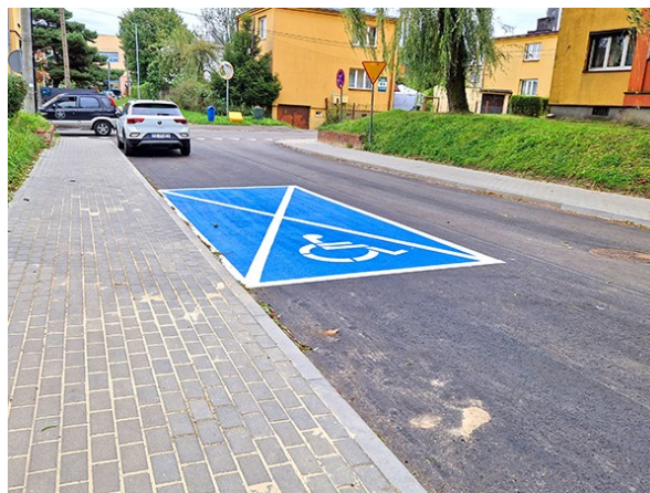
Fot. 24 Remont nawierzchni ulicy Pocztowej z nawierzchnią chodnika
