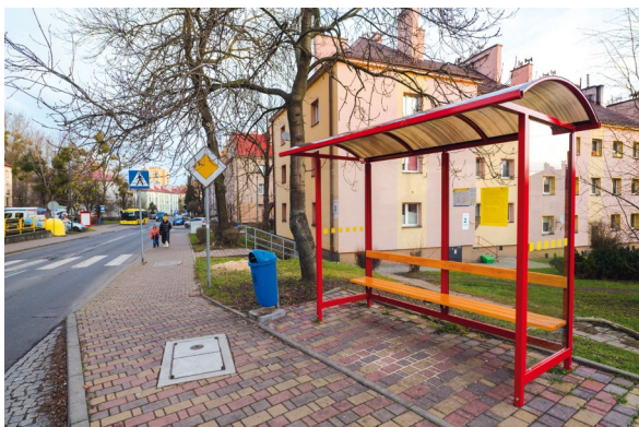
Fot. 17. Montaż 8 wiat przystankowych. Na zdjęciu wiat na ul. Grabowej.
