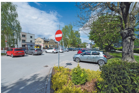
Fot. 1. Wymiana nawierzchni parkingu przy ulicy Kościelnej 36
