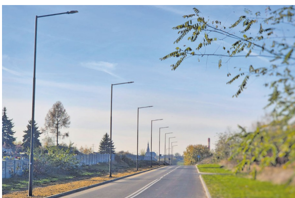
Fot. 21. Oświetlenie łącznika ul. Węglowej i ul. Jagiełły. Zamontowano 19 latarni ulicznych.
