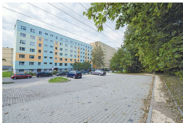
Fot. 2. Budowa parkingu przy ulicy Wróbla 2
