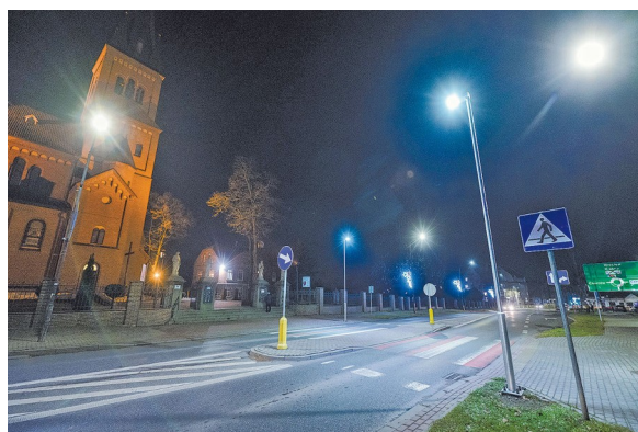
Fot. 20. Doświetlenie przejść dla pieszych. Na zdjęciu przejście na ul. Kościelnej 1.
