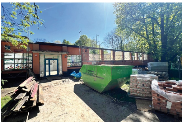
Fot. 37. Termomodernizacja przedszkola nr 12
