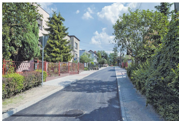
Fot. 6. Modernizacja nawierzchni ulic Ptasie Osiedle. Na zdjęciu ulica Kukutek.
