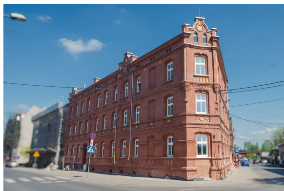
Fot. 32. Modernizacja kamienic w centrum miasta. Na zdjęciu budynek przy ul. Matejki.
