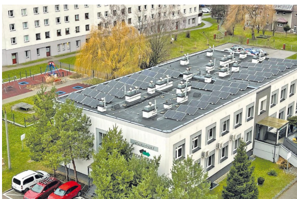
Fot. 33. Montaż instalacji fotowoltaicznych w infrastrukturze publicznej IV (PUP)
