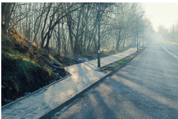
Fot. 25. Budowa chodnika na ul. Zwycięstwa.
