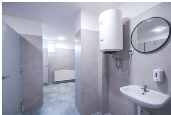
Fot. 38. Modernizacja budynku na potrzeby OIK
