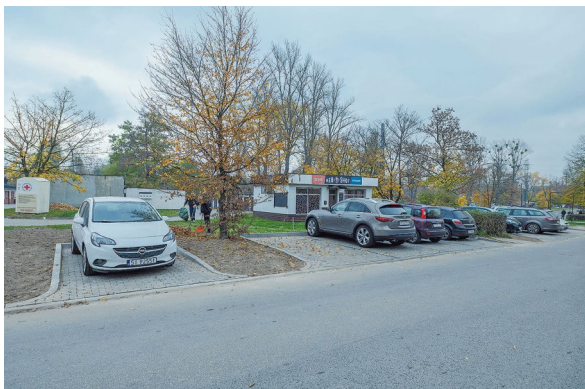
Fot. 29. Budowa parkingów i miejsc postojowych. Na zdjęciu parking przy ul. Korfanteo.
