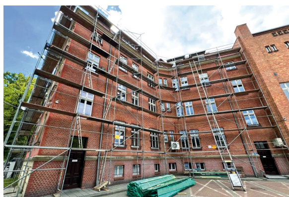
Fot. 40. Rozpoczęcie modernizacji zabytkowego budynku ratusza
