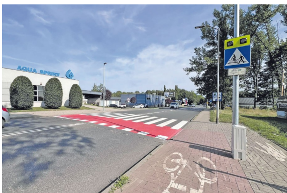
Fot. 19. Przebudowa przejść dla pieszych. Na zdjęciu przejście na ul. Śląskiej 100.
