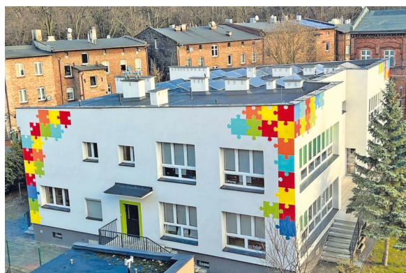
Fot. 34. Montaż instalacji fotowoltaicznych na budynkach przedszkoli nr 2 i 10
