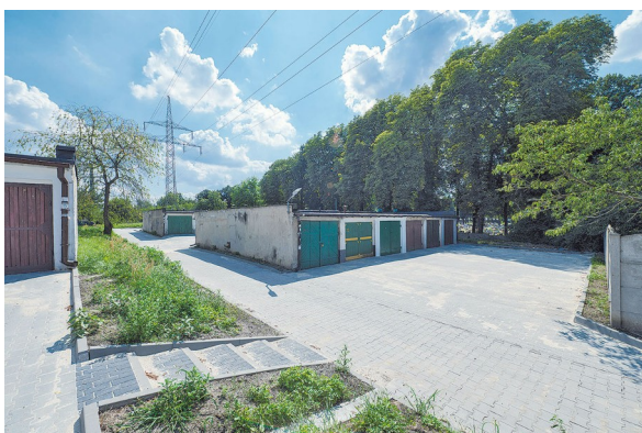
Fot. 3. Remont drogi dojazdowej do garaży wraz z podjazdami do garaży przy ul. Gansińca
