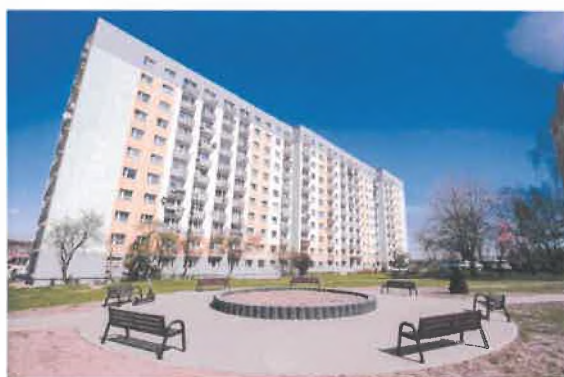
Fot. 5. Budowa skweru przy ul. Al. Młodych z montażem monitoringu
