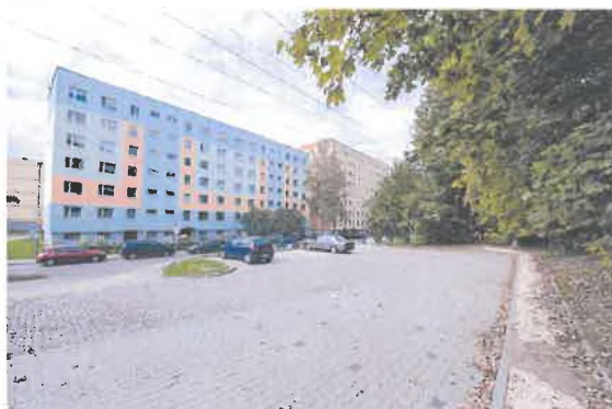
Fot. 2. Budowa parkingu przy ulicy Wróbla 2
