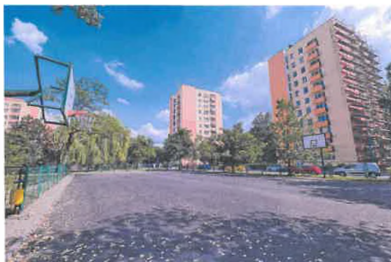
Fot. 30. Wymiana nawierzchni boisk osiedlowych. Na zdjęciu boisko przy ul. Okrężnej.
