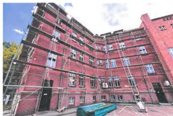
Fot. 40. Rozpoczęcie modernizacji zabytkowego budynku ratusza
