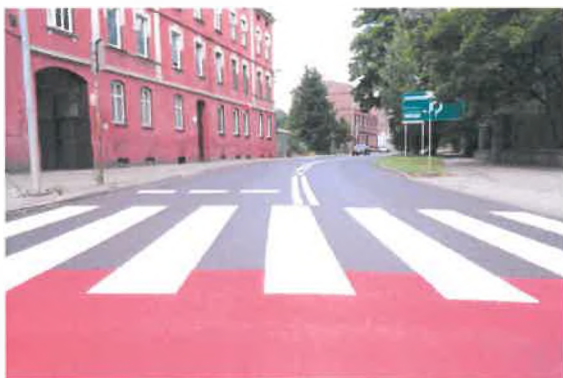
Fot. 23. Remont ponad 3 km nawierzchni dróg. Na zdjęciu ulica Parkowa.
