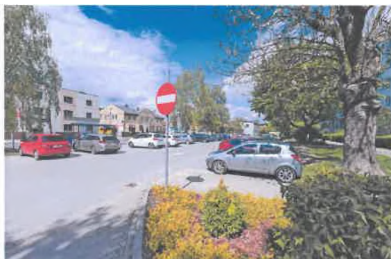
Fot. 1. Wymiana nawierzchni parkingu przy ulicy Kościelnej 36
