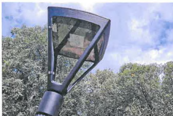
Fot. 18. Modernizacja oświetlenia ulicznego. Wymieniono 104 oprawy sodowe na nowe oprawy LED.
