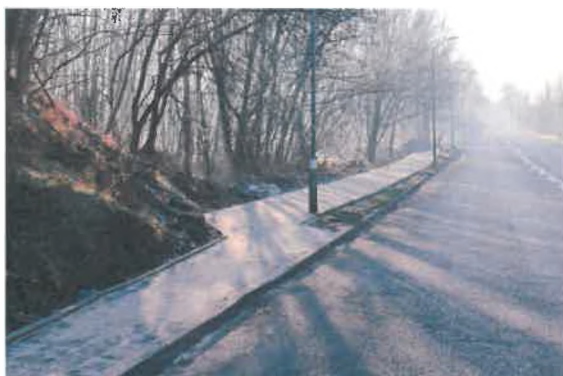
Fot. 25. Budowa chodnika na ul. Zwycięstwa.
