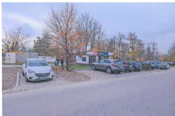
Fot. 29. Budowa parkingów i miejsc postojowych. Na zdjęciu parking przy ul. Korfantego.
