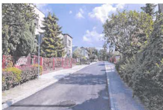
Fot. 6. Modernizacja nawierzchni ulic Ptasie Osiedle. Na zdjęciu ulica Kukułek.
