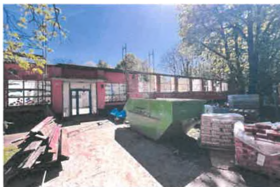
Fot. 37. Termomodernizacja przedszkola nr 12
