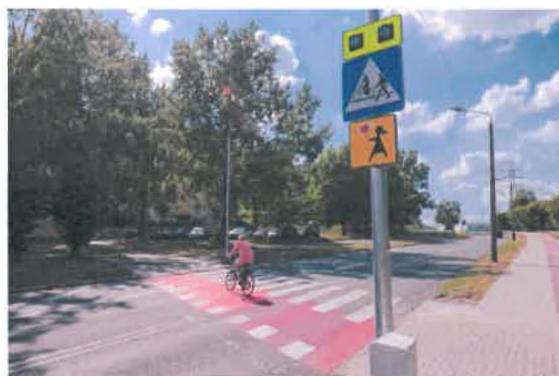
Fot. 26. Remont ścieżek rowerowych i traktów pieszko- rowerowych.
