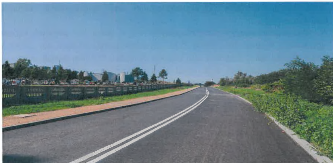
Fot. Nowe połączenie drogowe ul. Wł. Jagiełły z ul. Węglową w Siemianowicach Śląskich -Etap II (archiwum Urzędu Miasta)
