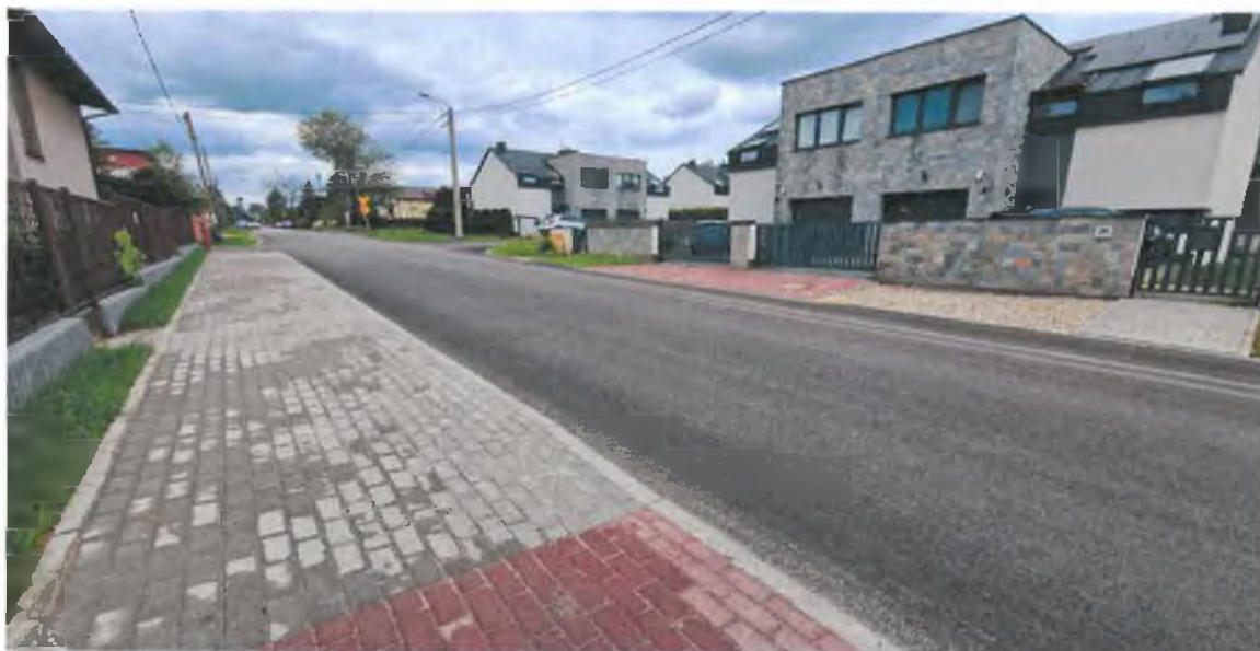
Fot. Wymiana nawierzchni na wybranych odcinkach dróg gminnych -ul. Krucza (archiwum Urzędu Miasta)
