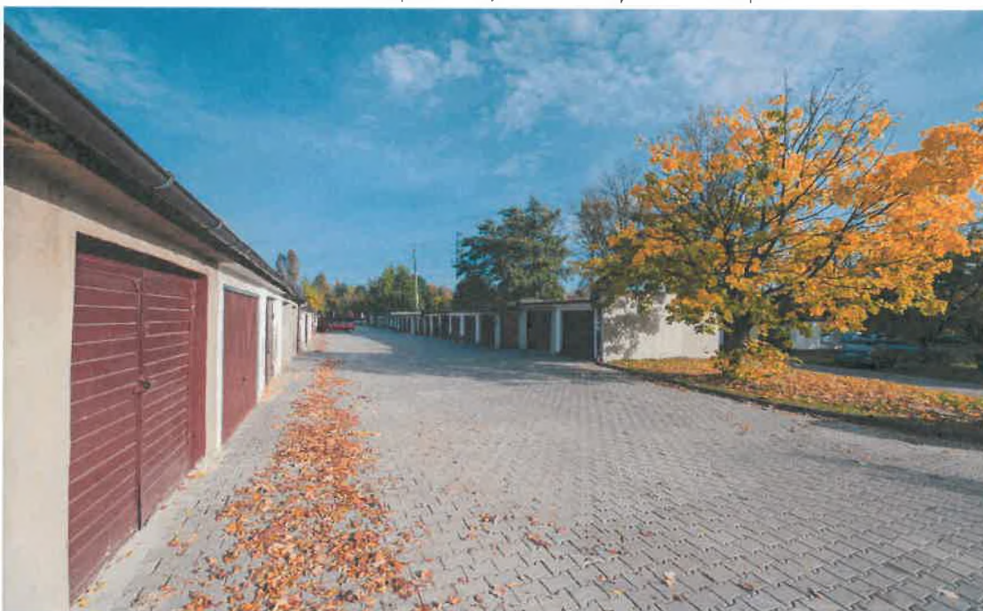
Fot. Wymiana nawierzchni drogi dojazdowej do garaży przy ul. Korfantego (archiwum Urzędu Miasta)
