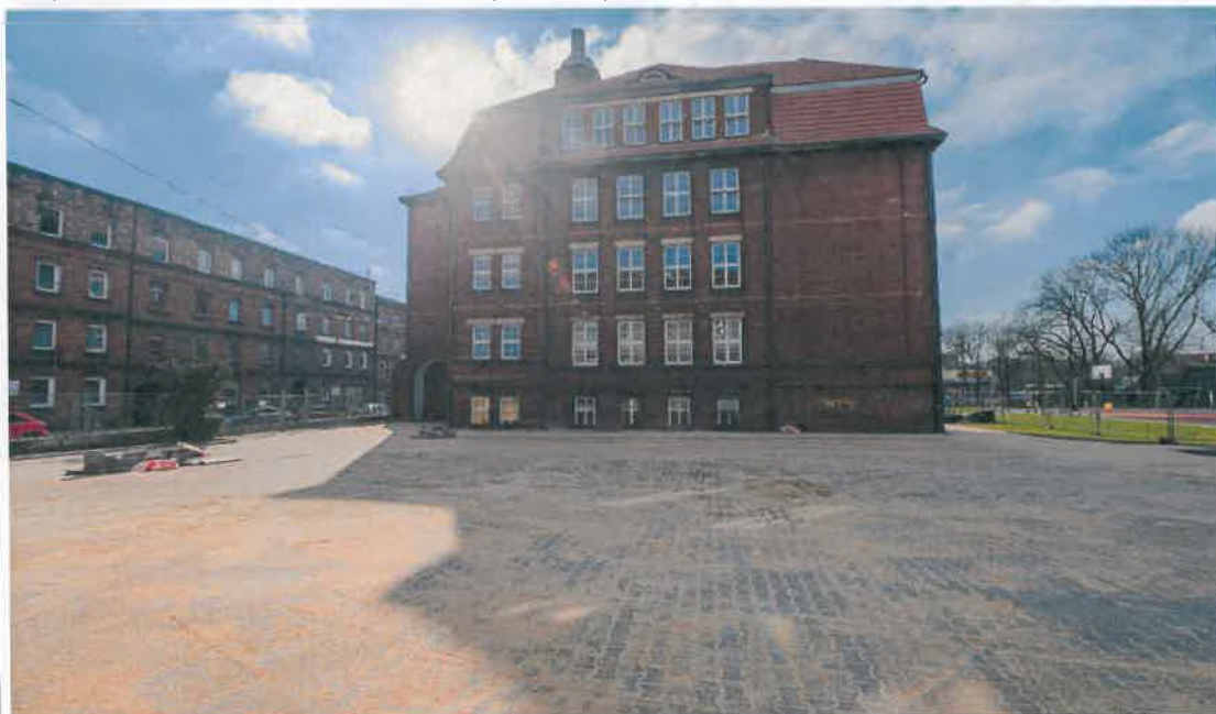
Fot. Wspólny projekt SP 11 oraz SP 5 - wymiana nawierzchni ul. Słowackiego (archiwum Urzędu Miasta)
