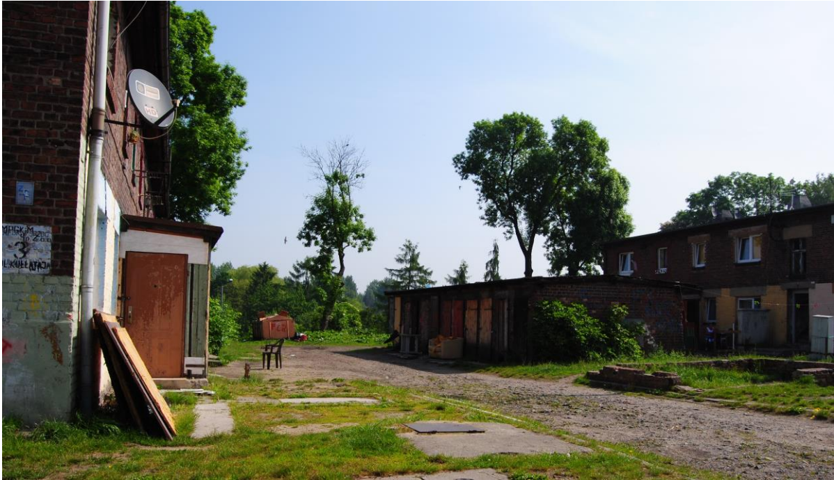
Fot. 5. Nowy Świat – fragment wewnętrznej ulicy osiedla/ Źródło: UM Siemianowice Śląskie
