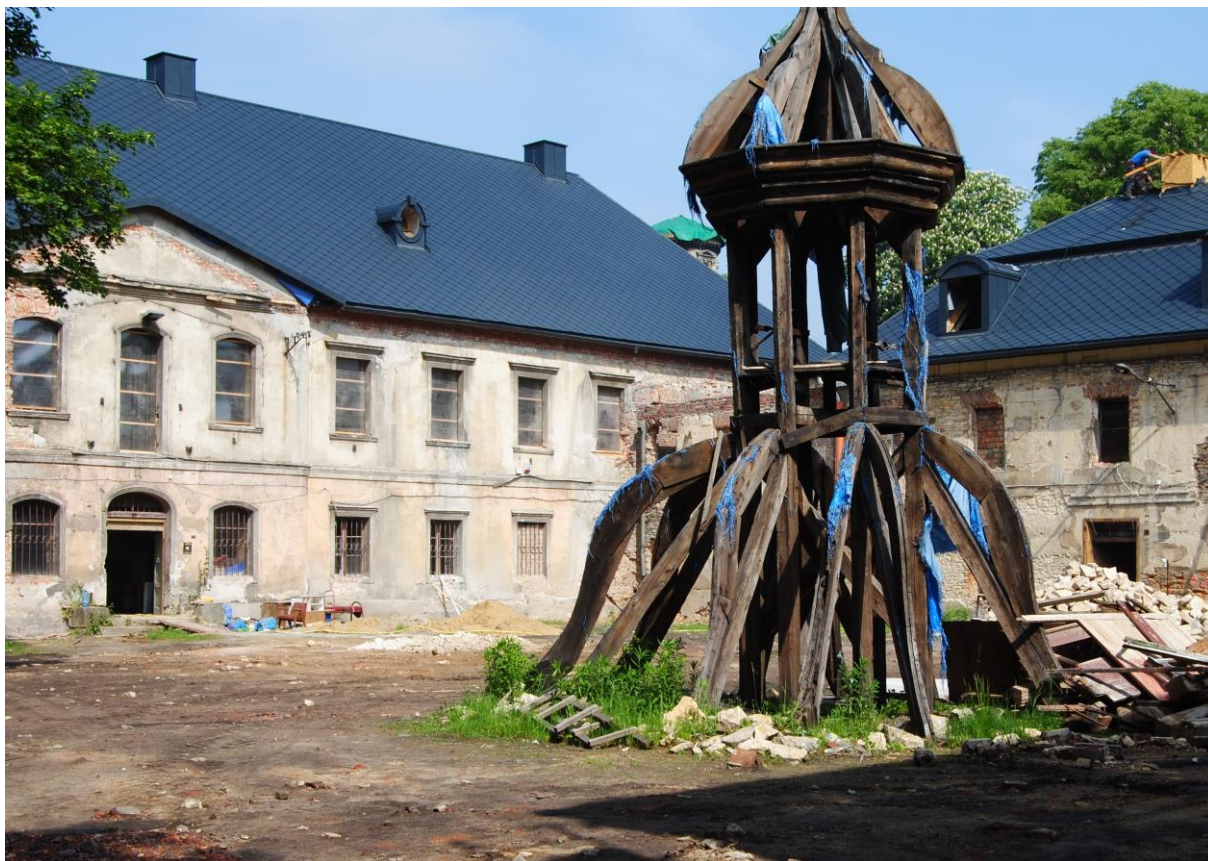
Fot. Pałac Donnesmarków/ źródło UM Siemianowice Śląskie
